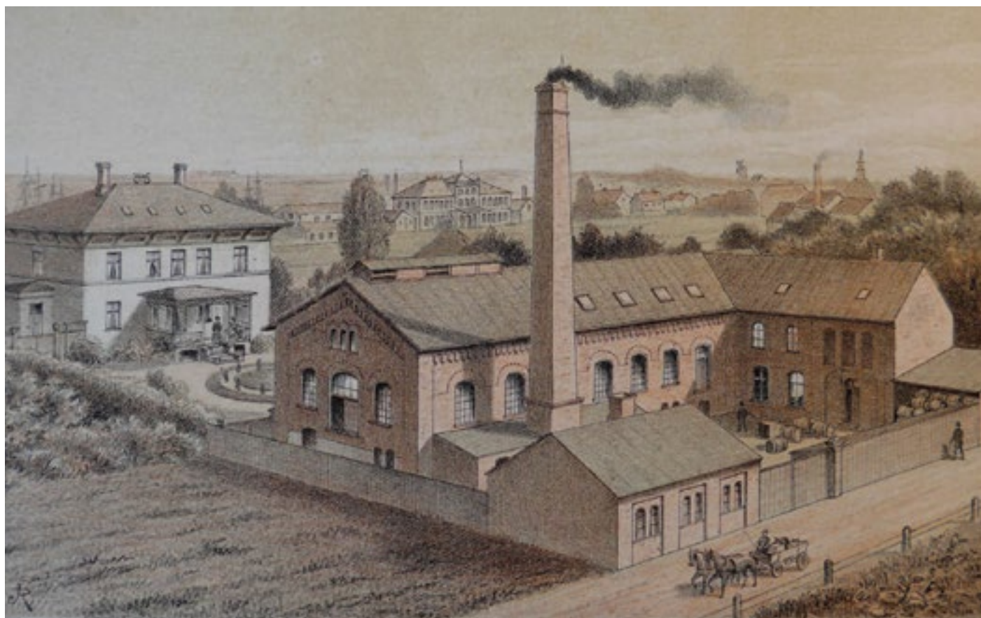
Kaalunds Sæbefabriker, formentlig omkring 1900. Fabriksanlægget er endnu beskeden. Til venstre direktørboligen, i dag Fredericiagade 25
