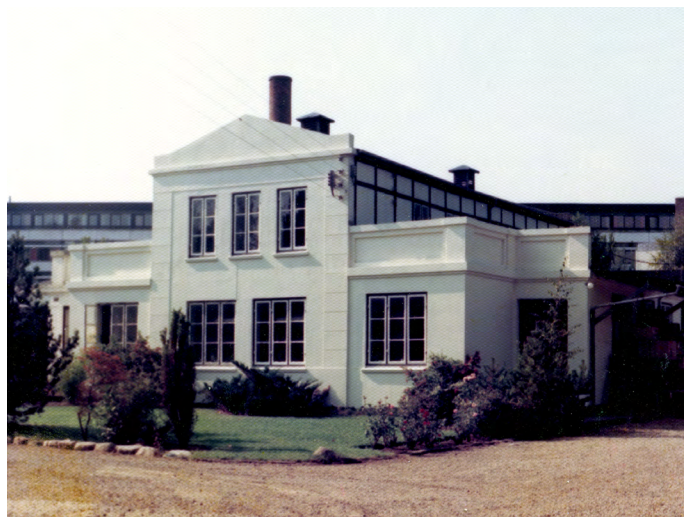
Koldinghus Margarinefabriks bygning i 1976. Margarineproduktionen var ophørt, men nu holdt Silcon til her. Foto: Teknisk Forvaltning, Kolding Kommune.
